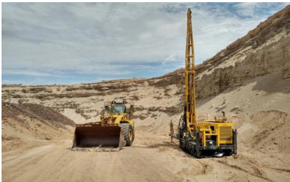
Bohrgerät auf dem Copperstone-Projekt in Arizona (Foto: Hoffmann / TK News Services UG)
